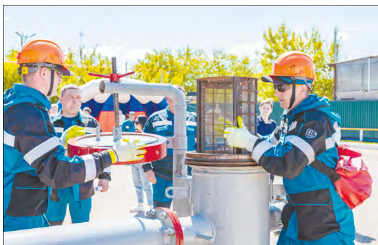
Смены по подготовке нефти переключаются с основного насоса на резервный / ФОТО СЕРГЕЯ ТРУСОВА
